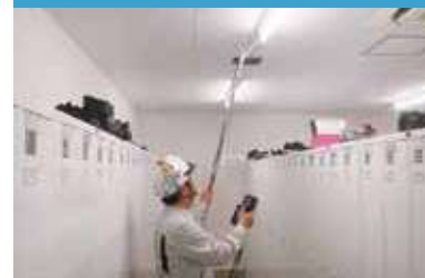
侵入経路調査
