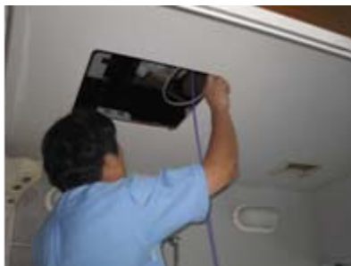
浴室の天井裏に入る点検口
