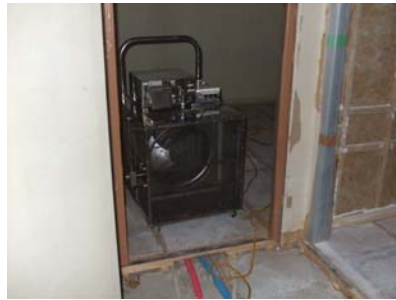
ススの清掃・燃焼した部材を撤去した後 オゾン燻蒸脱臭
